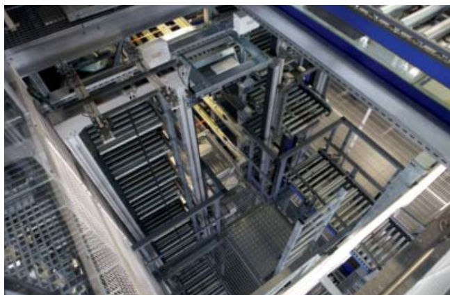
Die Förder- und Aufzugstechnik erstreckt sich über vier Etagen.
